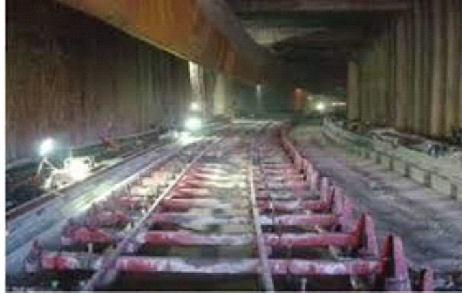
Imagen 4: Colocación de losa portante
