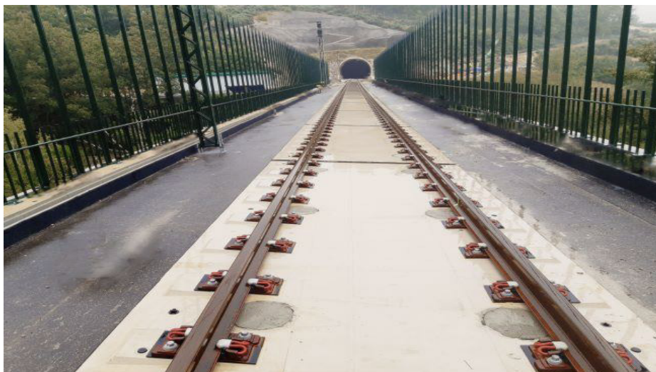
Imagen 5: Vía en placa en un puente.
