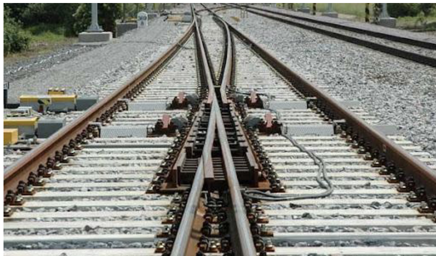
Imagen 10: Aparato de vía controlado por motores
