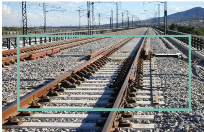
Imagen 4: Aparato de dilatación de riel.
